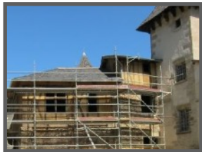
Ci-contre: Restauration des Torchis du Manoir de la Salvanie à Laguenne
